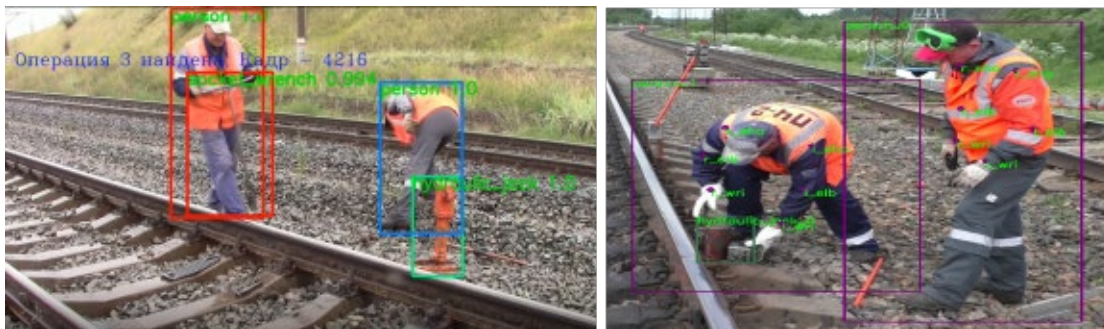
Рисунок 1 – Примеры работ на железнодорожных путях Figure 1 – Examples of work on railway tracks
